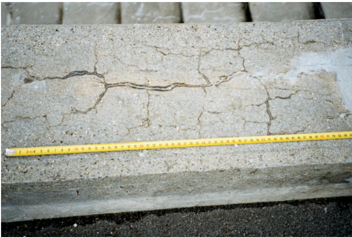
Seitenmauer Fussgängerunterführung im Kt. Neuenburg: Im Zentrum der dunklen Rissfüllungen ist das helle Gelprodukt der AAR erkennbar (Bilder: B-I-G, Büro für Ingenieurgeologie)
